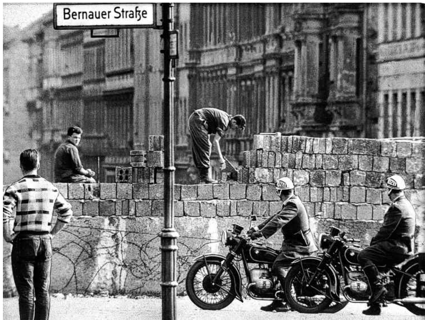
Arbeiten an der Mauer, die an der Bernauer Straße die Bezirke Wedding im Westen und Pankow im Osten teilte.
